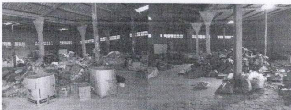
Figura 4-25 - Galpão de Triagem.
